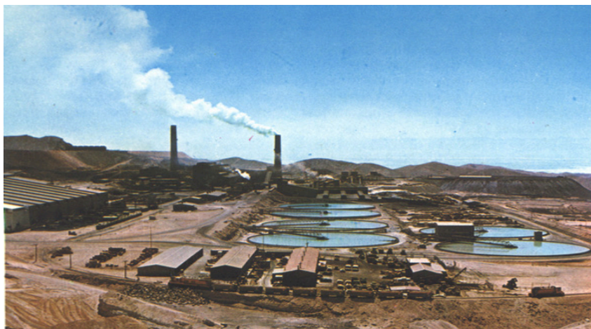
Figura 4. Panorámica de la Planta de Sulfuros de Chuquicamata
